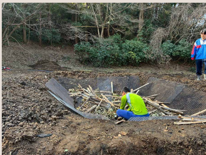
5m 程度のすり鉢状の穴を掘り
