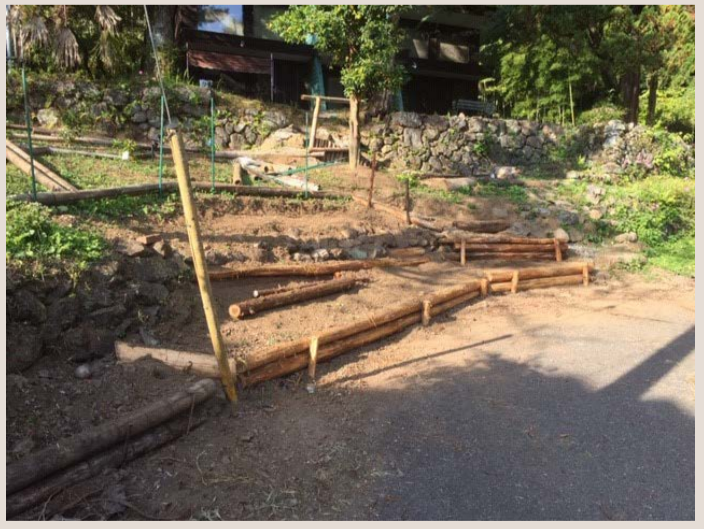
伐採材を用いた土留め
